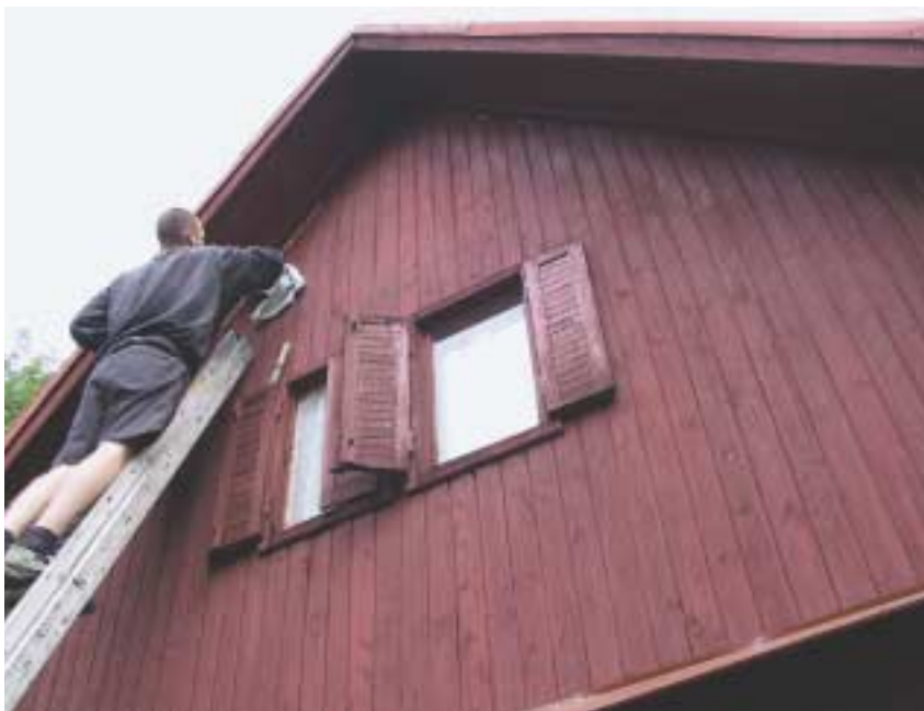
Zabezpečení verandy chaty před padajícím trusem - instalace jednoduché kovové stříšky v prostoru nad verandou a částečné zatmelení mezery v obložení, pod kterým sídlí kolonie netopýrů
